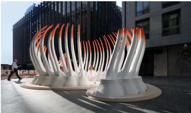
Рис. 8. В одном примере 30 000 бутылок с водой были переработаны в нить для 3D-печати общественного сооружения в Дубае (выше). Павильон демонстрирует, как 3D-печать может быть применена к творческим структурам с использованием материалов, которые в противном случае были бы выброшены.
